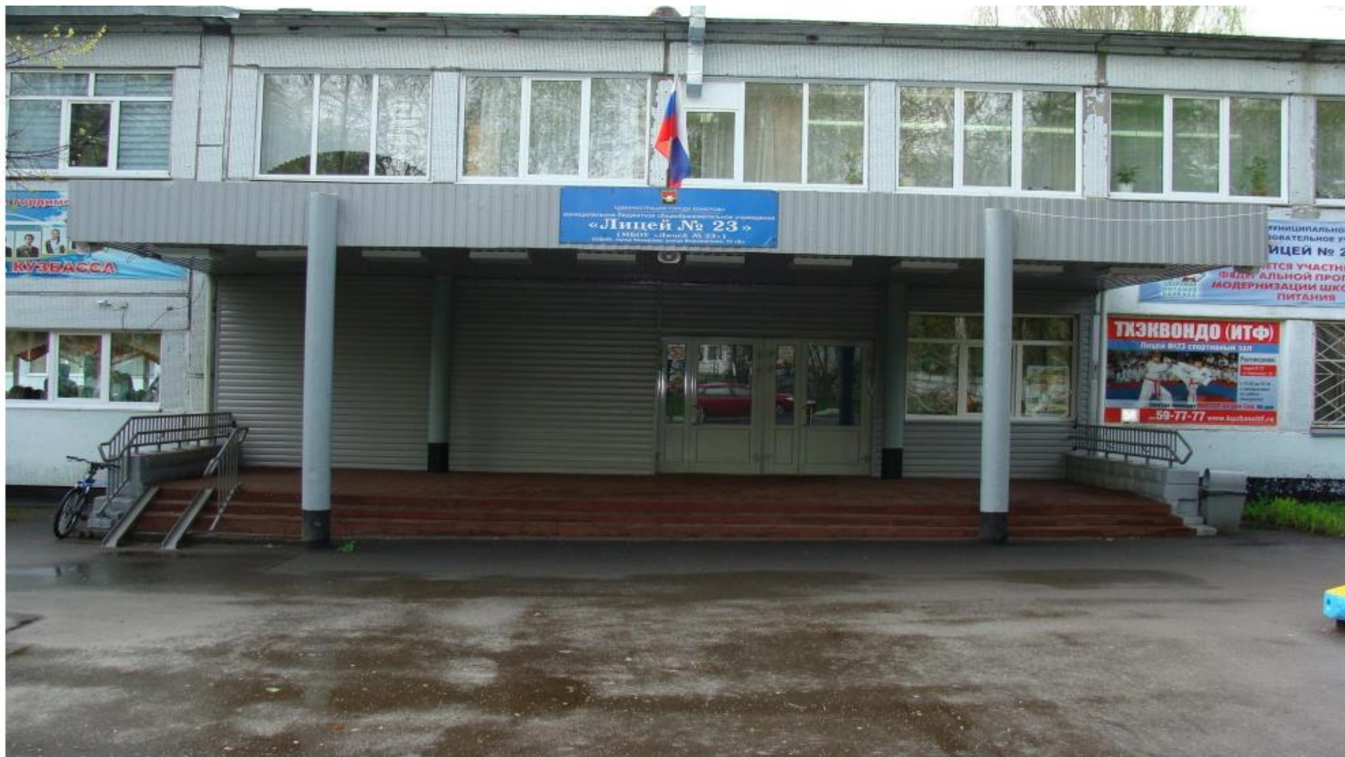
Рис. № 17 «Лестница наружная»
