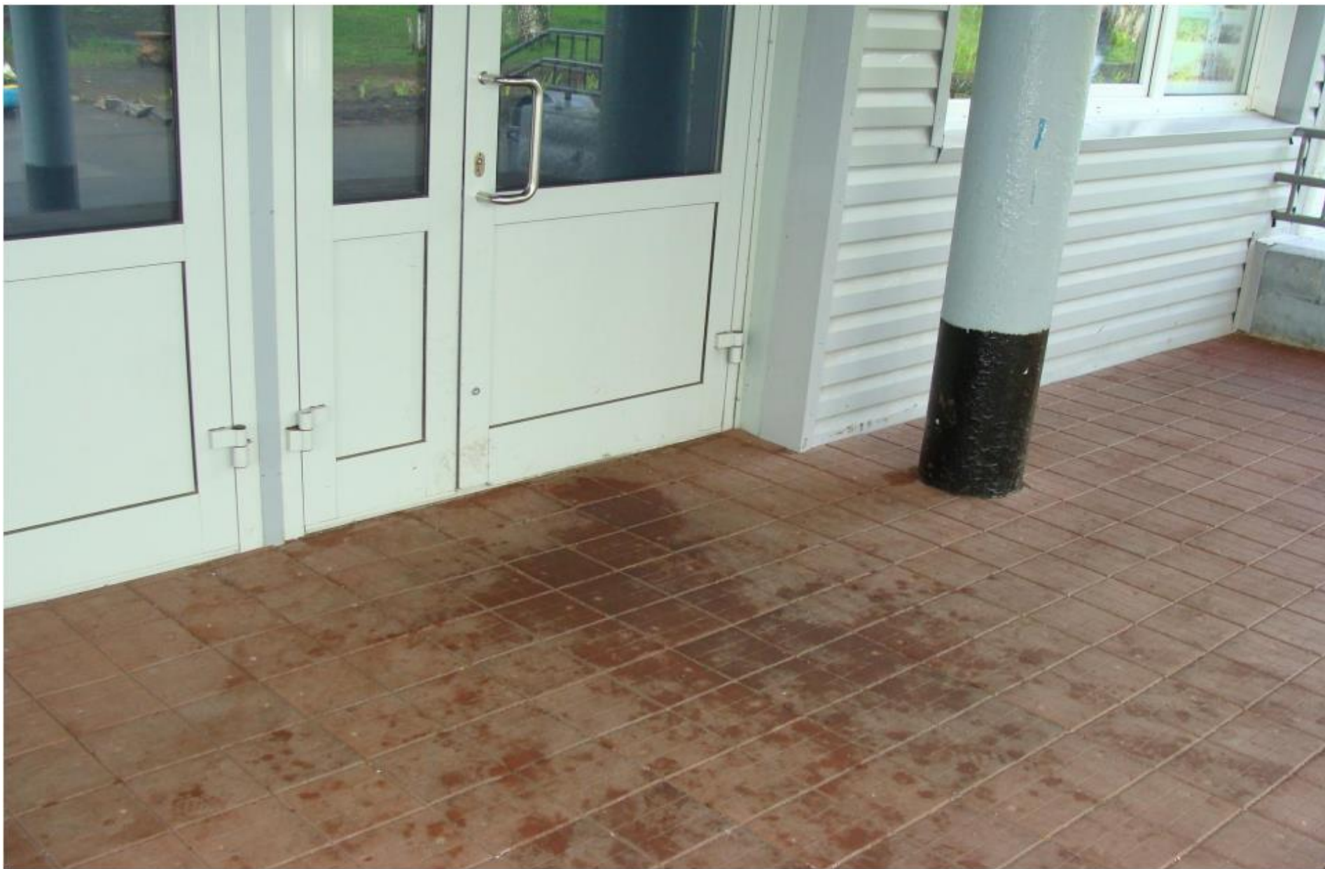
Рис. № 19 «Входная площадка (перед дверью)»
