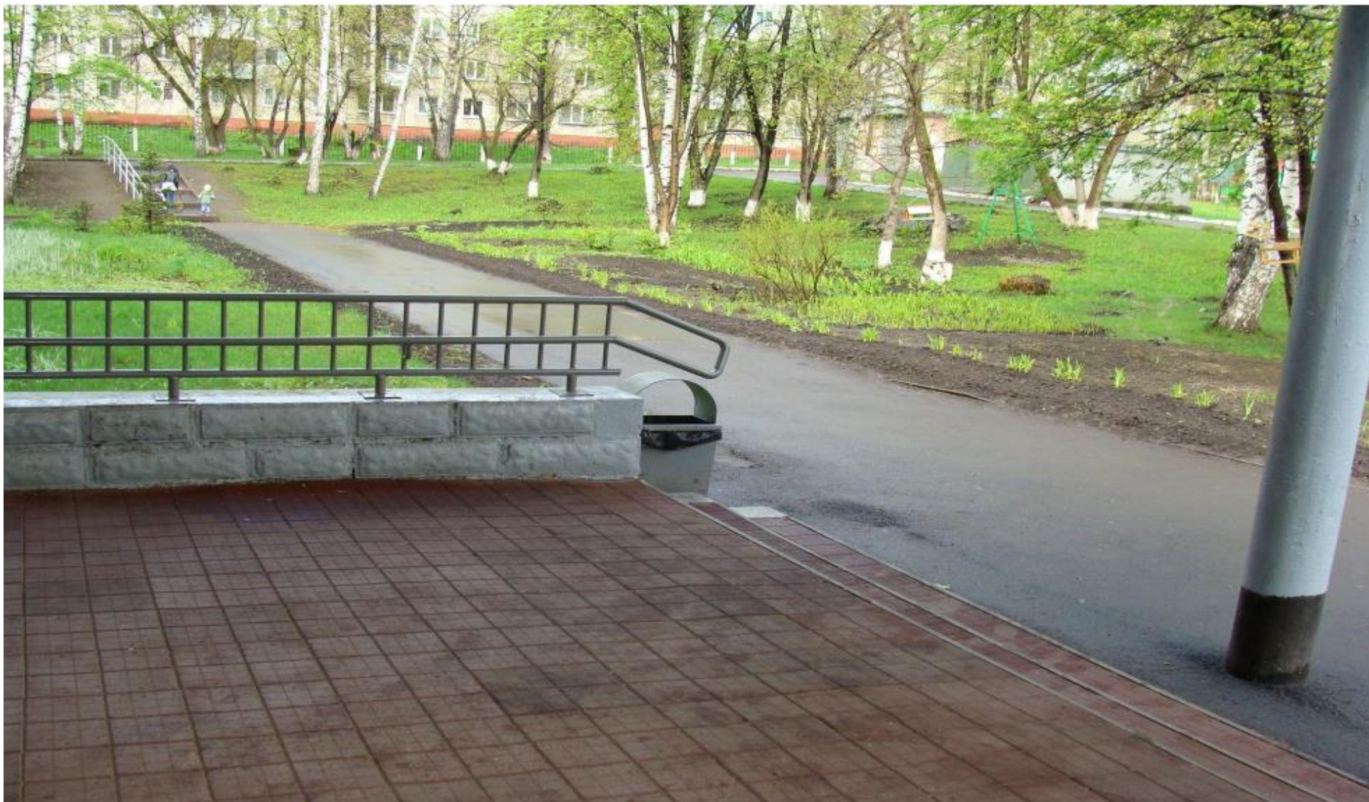
Рис. № 18 «Лестница наружная»
